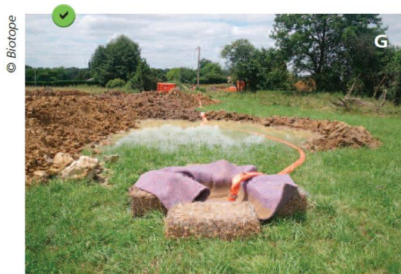
Figure 15 : Exemple de mesure de gestion des MES (source Biotopie)
